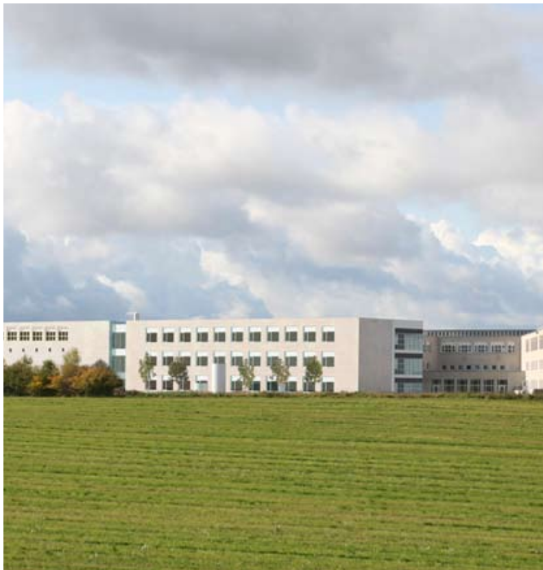
2.600 m 2 tilbygning til Novo Nordisk, Måløv.
